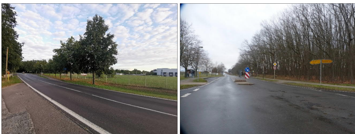
Abbildung 54: L16 Blickrichtung Pausin und L 16 Blickrichtung Autobahnbrücke
