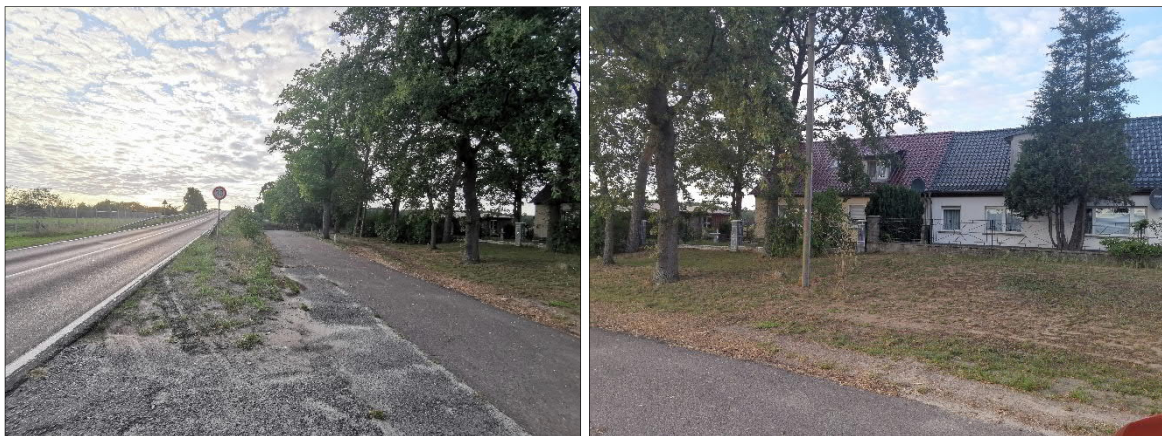
Abbildung 53: Brücke L16 über BAB aus Blickrichtung Süden und Wohnhäuser an der alten L16
