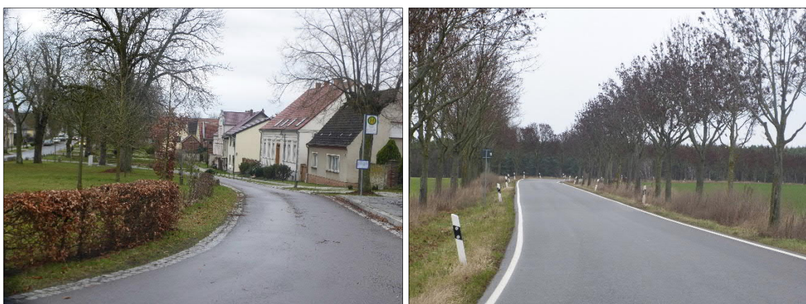
Abbildung 63: Ortslage Perwenitz und Ausfahrt Perwenitz Richtung Nord
